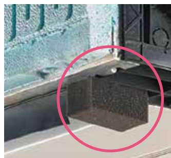
JOINTS DE PERMÉABILITÉ À L'AIR
