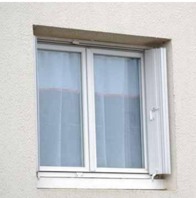
Panneaux composés de vantaux pvc alvéolaire de 14 mm d'épaisseur, cadre aluminium.
