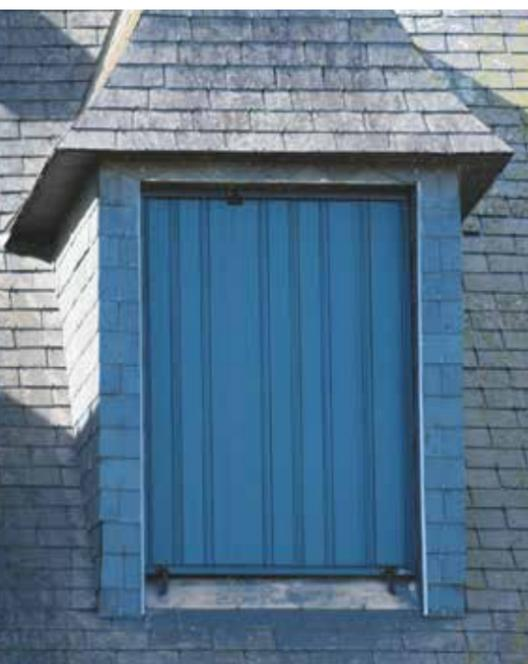
Tabliers composés de vantaux en aluminium extrudé de 14 mm d'épaisseur, cadre aluminium.
